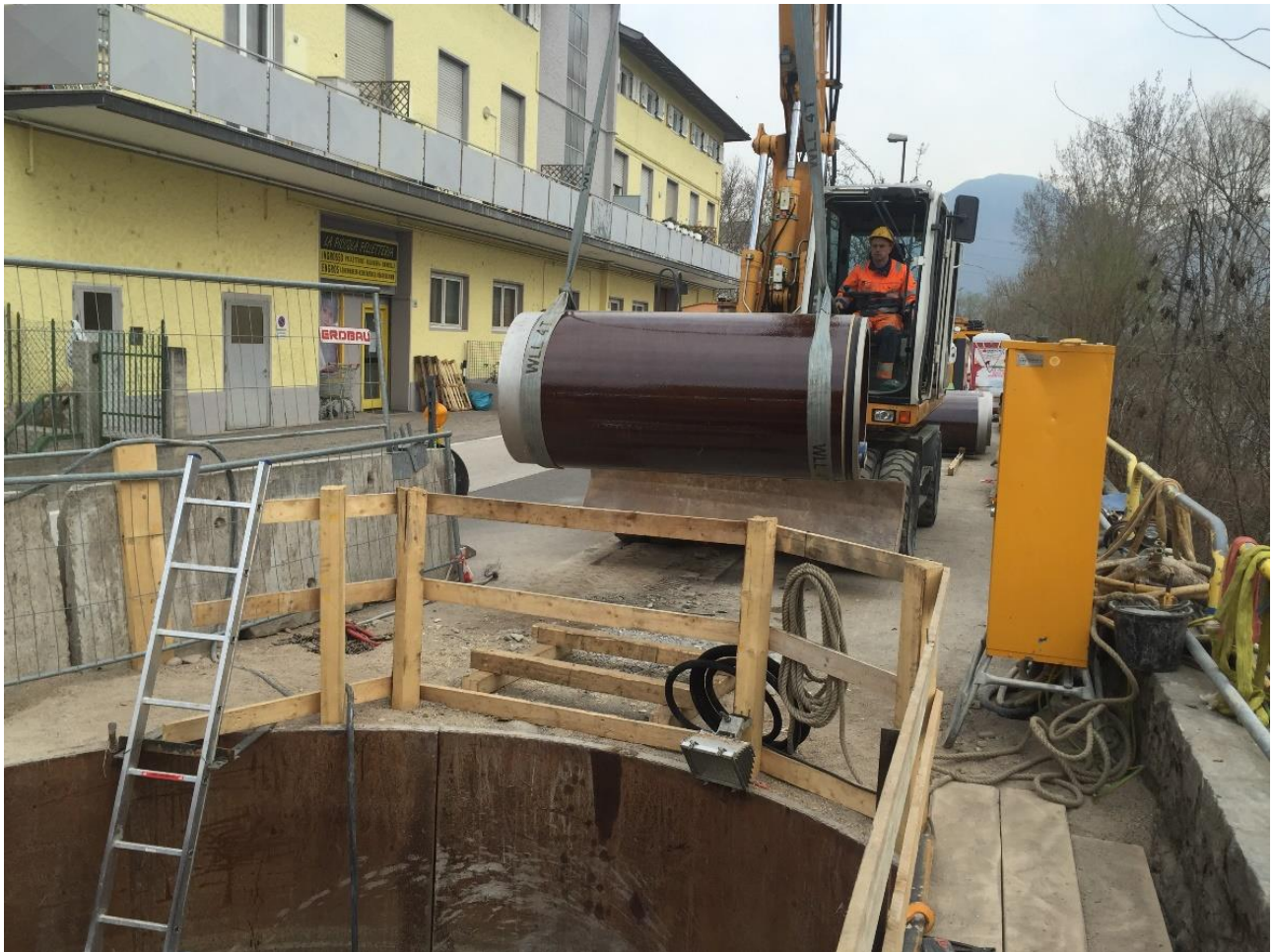
Figura 8-F : Cantiere microtunnelling pozzo di spinta
