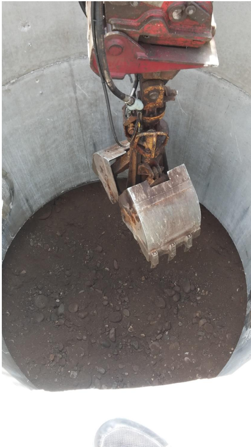
Figura 7-E : Scavo con rostro interno pozzo autoaffondante
